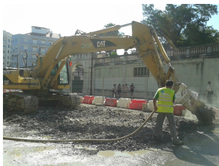
Figura 12 – Aspersão do pavimento a ser levantado.
