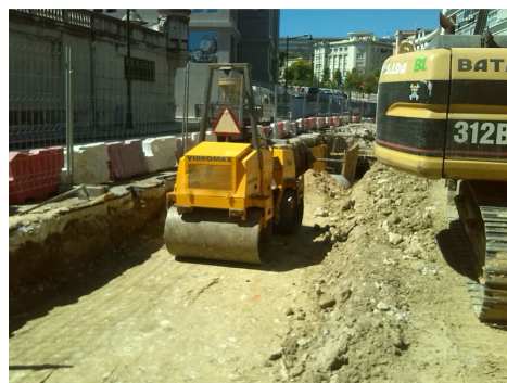
Figura 7 – Aterro de valas e compactação.
