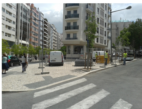
Figura 1 – Montagem de estaleiro social.
