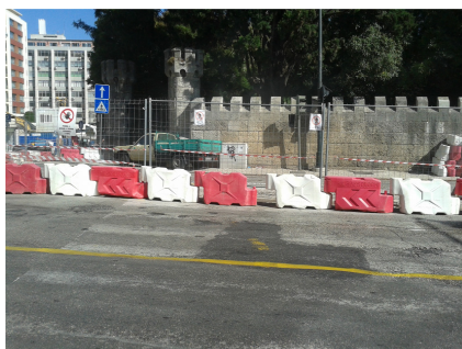
Figura 14 – Vedação da zona afectada à obra.
