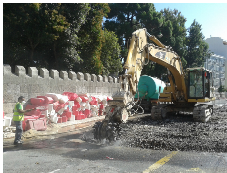
Figura 3 – Levantamento de pavimento.
