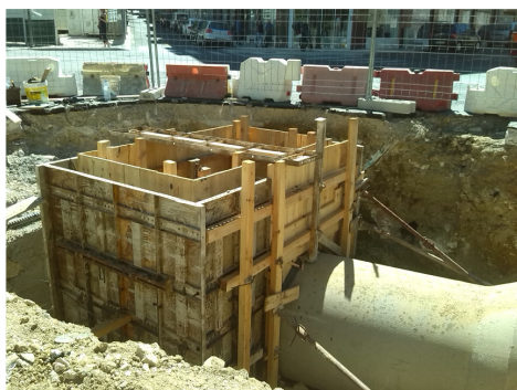
Figura 6 – Aplicação de cofragens.
