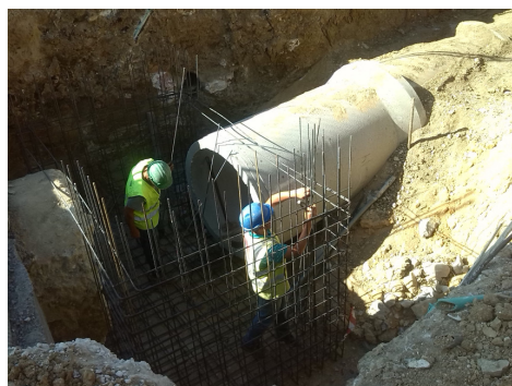
Figura 5 – Armação de ferro para execução de caixas.
