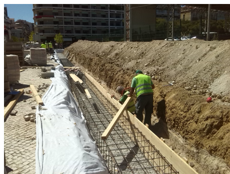
Figura 11 – Execução de cofragem.
