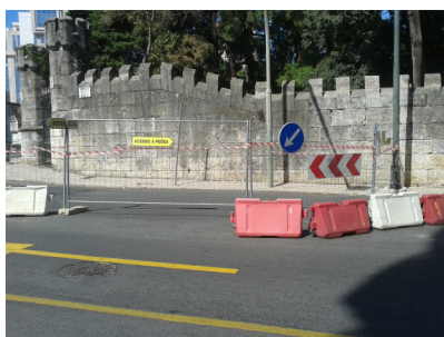
Figura 15 – Manutenção de caminhos pedonais nas zonas adjacentes à obra.
