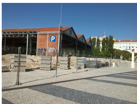
Figura 8 – Vedação e delimitação da zona de trabalhos.
