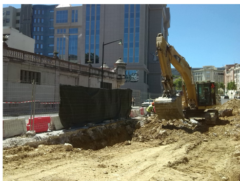
Figura 4 – Abertura de vala para execução de colector.
