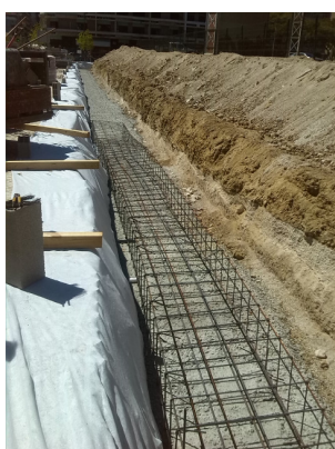
Figura 10 – Execução de armação de ferro.
