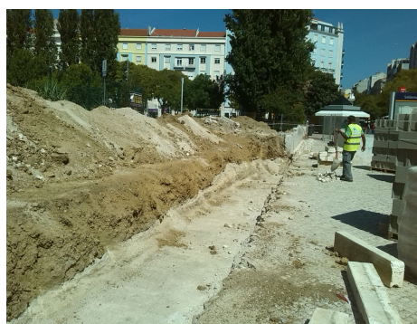
Figura 9 – Levantamento de lancis e maciços existentes.
